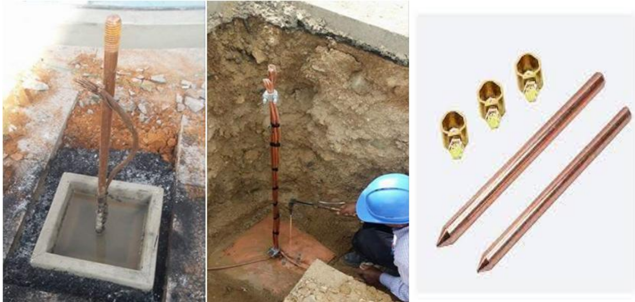
شكل رقم ( 7 ) عمود التأريض
