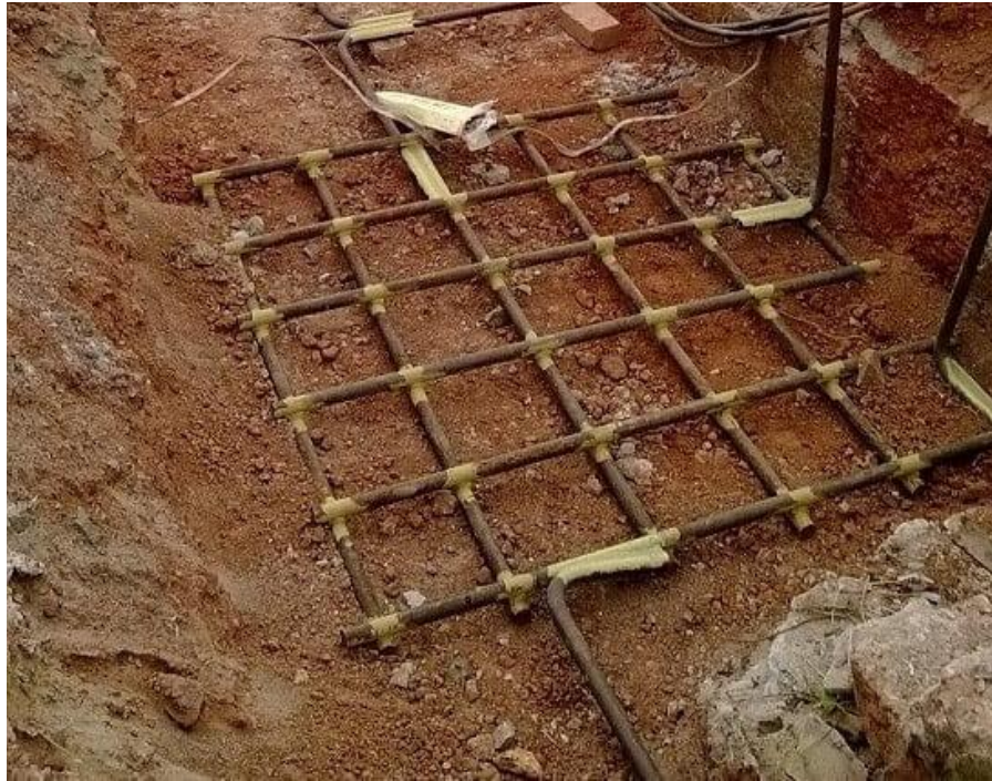
شكل رقم ( 6 ) يوضح عمل شبكة ارضي بداخل التربة
