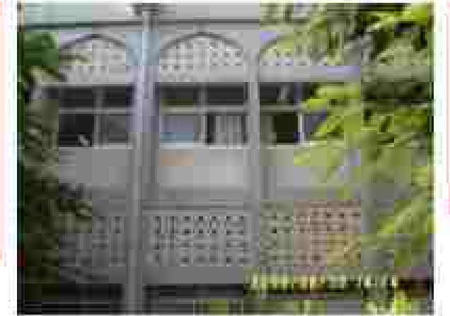
شكل رقم (١١) يظهر نوع آخر من الفتحات يستخدم الألمنيوم في التصنيع وذلك لتوفير مزيد من الأمان إضافة لعدم التعرض للحرائق من الخارج في الأماكن التي تستخدم الألمنيوم فيها.
