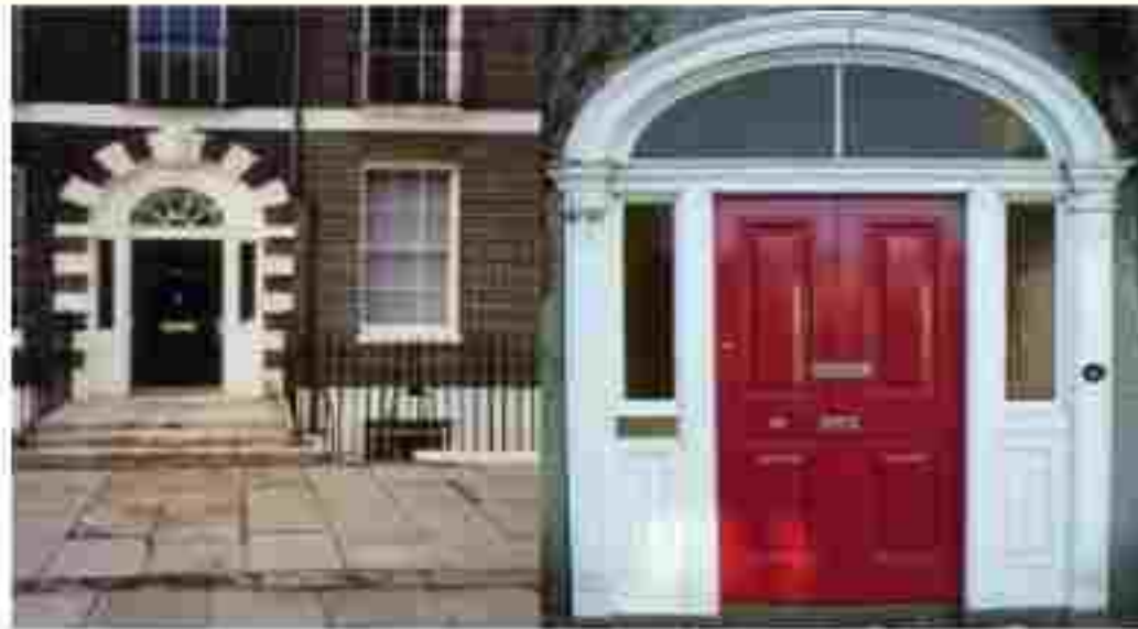
شكل رقم (٢٦) يظهر نماذج لأبواب الخارجة للمداخل المنزلي.
